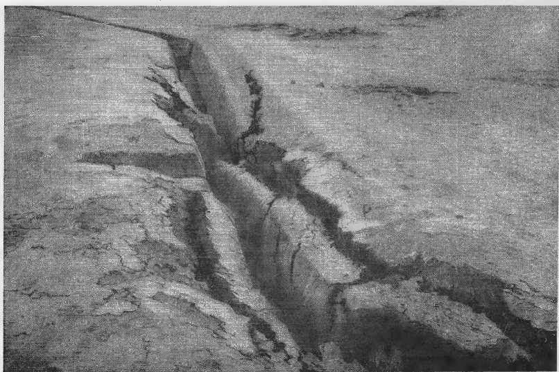
Рис. 109. Траншея без одежды крутостей, находившаяся в зоне средних разрушений
